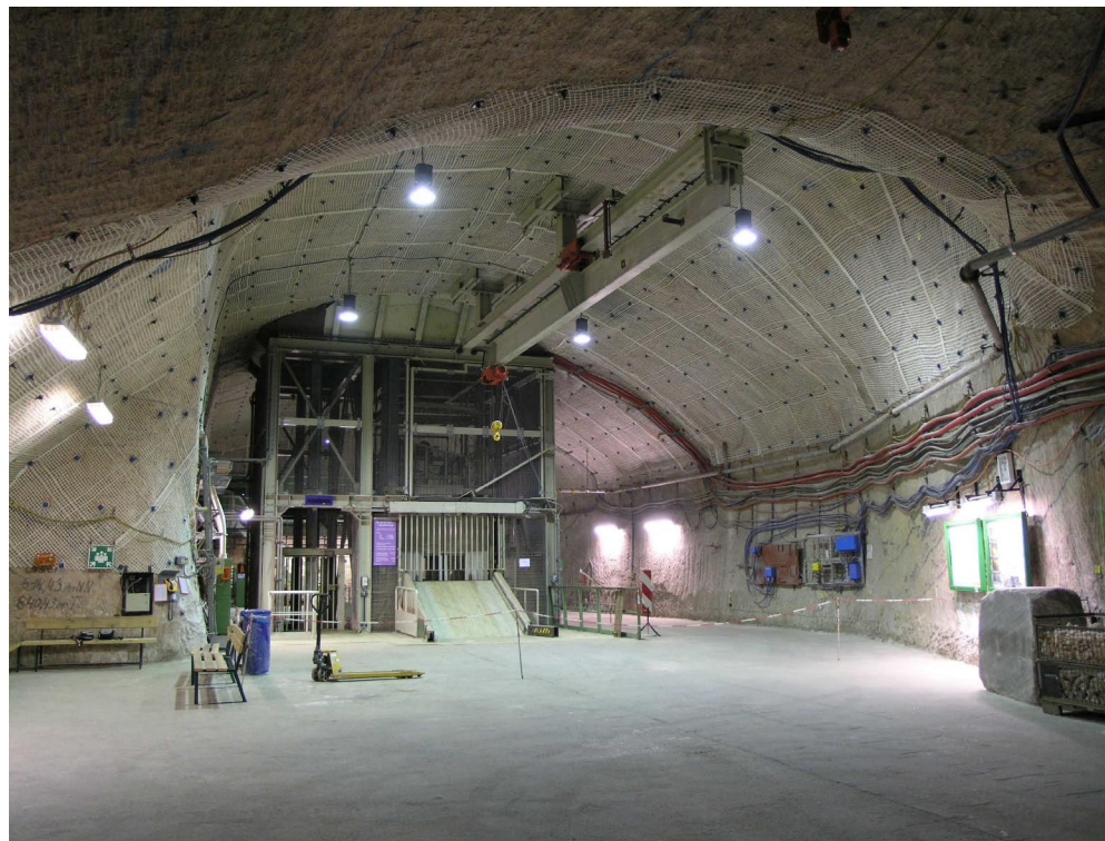
Gorleben untertage: Am Förderschacht
